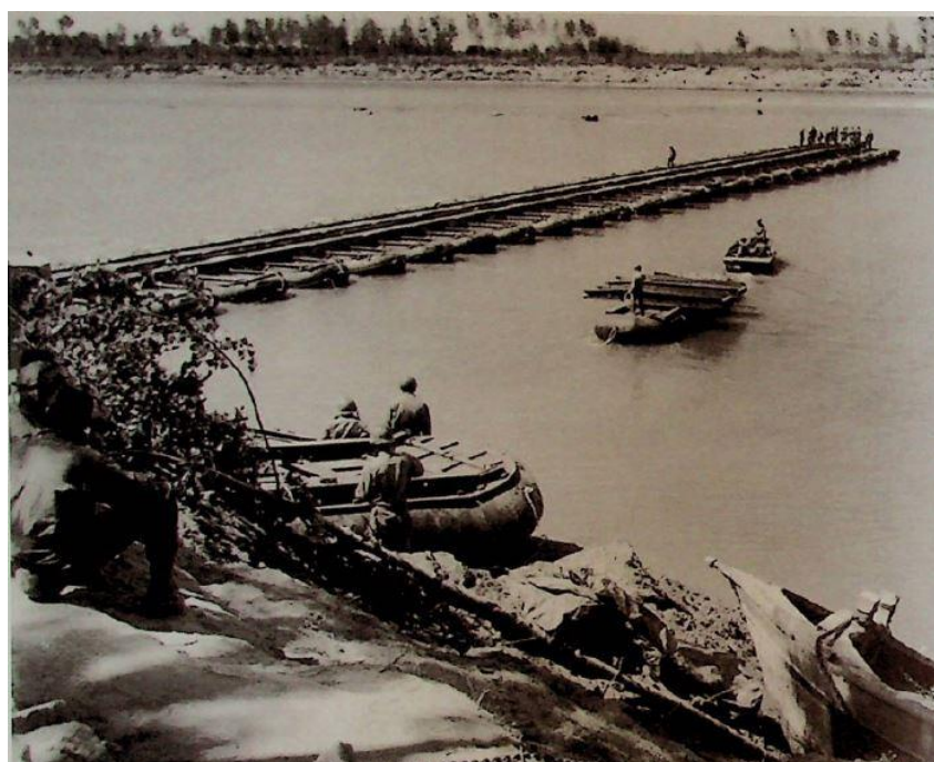
Immagine 43 - Operazioni di costruzione del ponte militare americano flottante su gommoni gonfiabili a Bonizzo (MN) il 25 Aprile 1945
